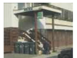
Schody do budovy Obvodného oddelenia PZ Pezinok Jozef Veverka
